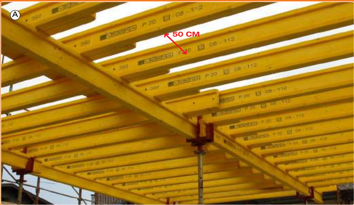
A) In secondo luogo posizionare le travi ripartitrici a 50 cm d'interasse l'una dall'altra. B) Posizionare i pannelli in legno e i puntelli intermedi.
