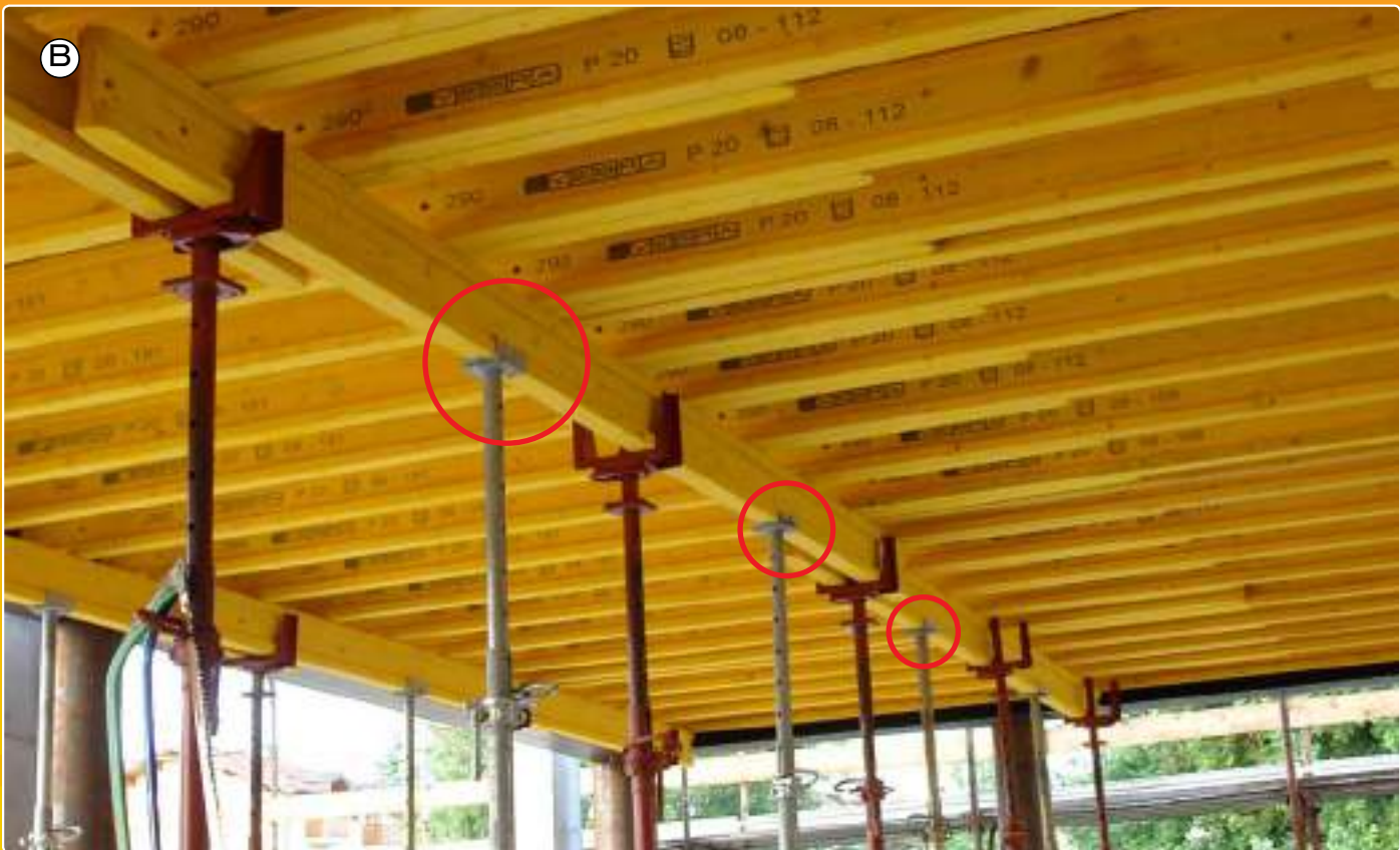
A) In secondo luogo posizionare le travi ripartitrici a 50 cm d'interasse l'una dall'altra. B) Posizionare i pannelli in legno e i puntelli intermedi.
