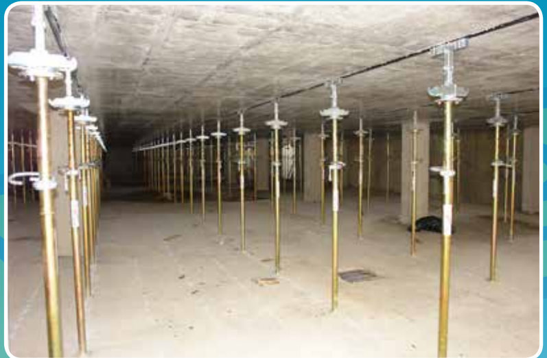
SOLAIO PIENO DOPO IL DISARMO DELLE CASSEFORME
