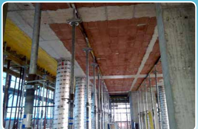
SOLAIO TIPO LATEROCEMENTO DOPO IL DISARMO DELLE CASSEFORME
