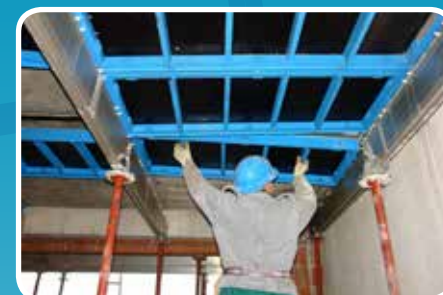
DISARMO PANNELLI E TRAVI
