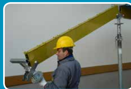
POSIZIONAMENTO TRAVI
